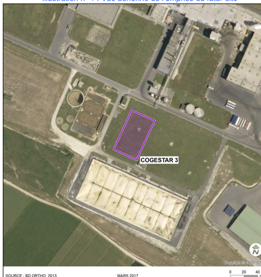
Illustration n° 1 : Vue aérienne de l'emprise du futur site
